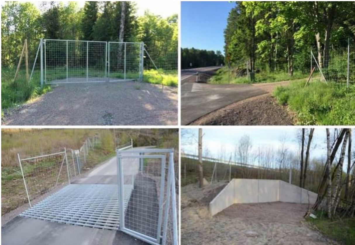
Figur 90 Exempel på grind, öppning, färäst och viltuthopp vid anläggning av faunastängsel. Bildkälla: Trafikverket
