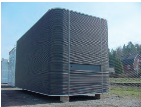
Figur 3.13 Exempel på prefabricerat eldriffsutrymme.
