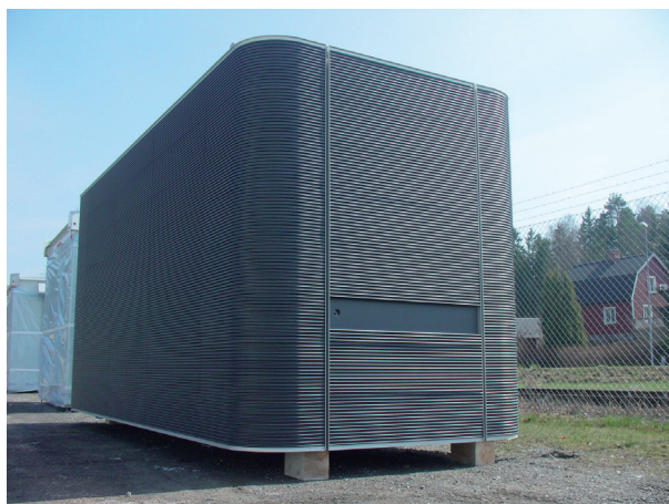
Figur 3.13 Exempel på prefabricerat eldriftsutrymme.
