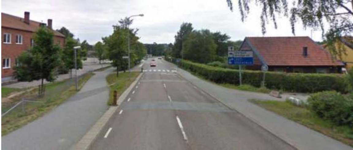
Figur 28. Väg 257 Tungelstavägen vid Tungelsta skola, västlig riktning.
