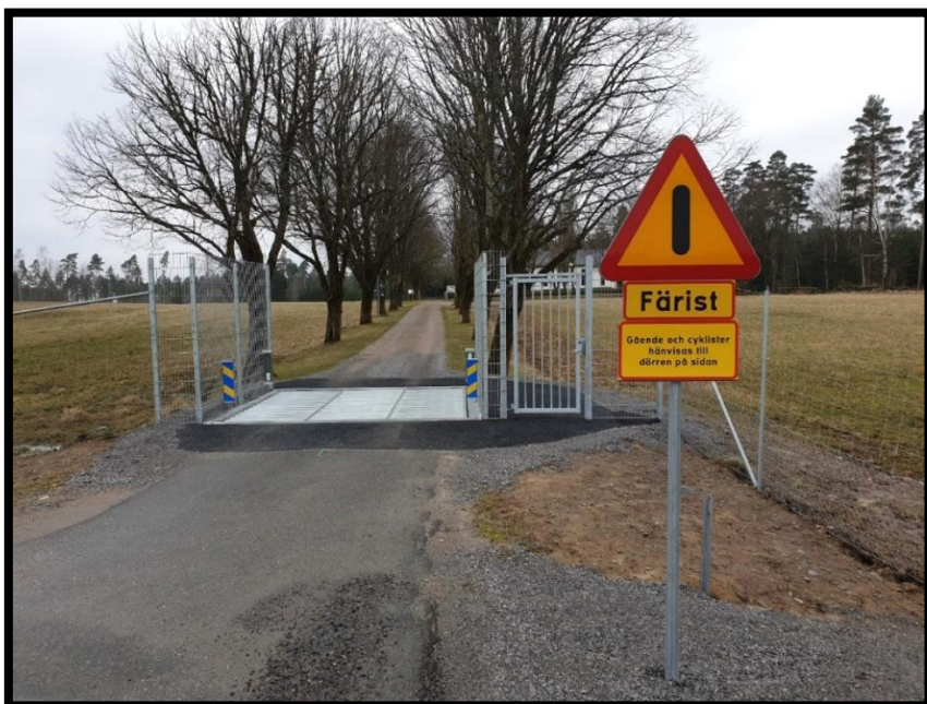
Figur 18. Exempel på utformning färister med grind för gående.
