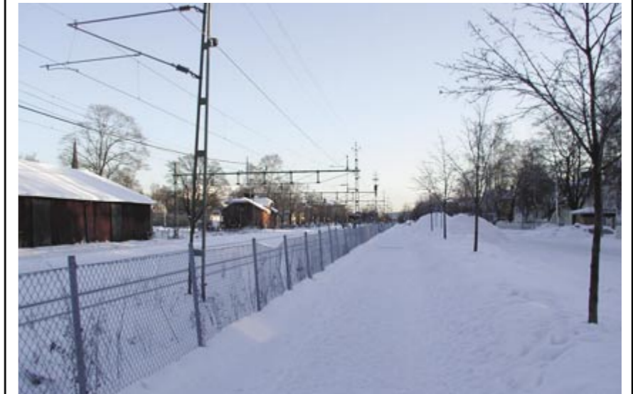
Väst på stan idag, sett från Södra järnväggatan mot Västra station.
