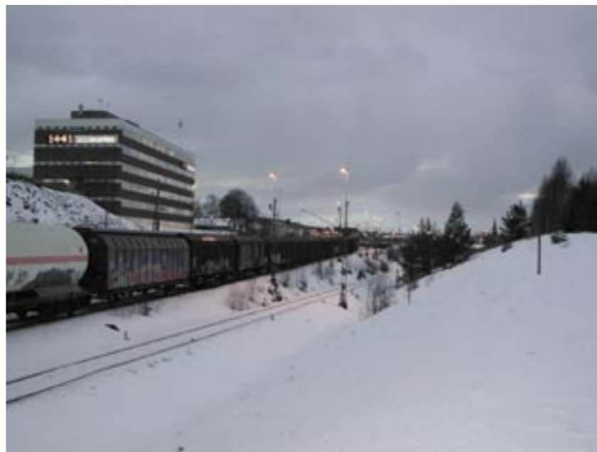
Rangering pågår, godståg på utdragsspåret.
