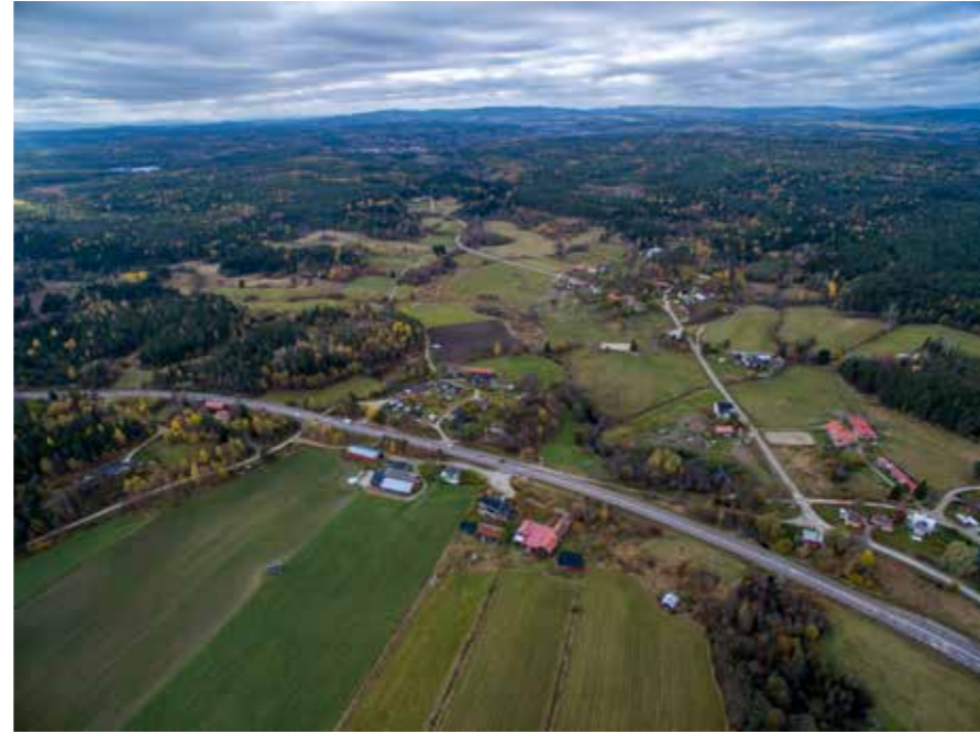
Figur 4.3:2. Vatträngs dalgång sett från öster, med den öppna odlingsmarken och bebyggelsen. Befintlig E4 syns i nedre bildkant.
