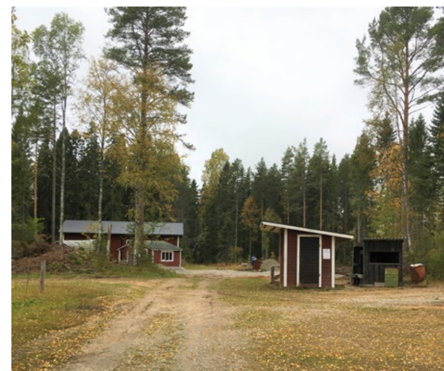
Figur 8.6.2 Skjutbanan vid Sandbäcken, vy mot byggnader.
