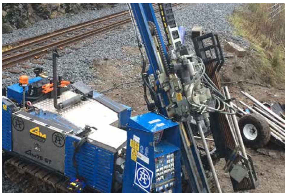
Figur 5.1:8 Jordprovtagning med geoteknisk borrhandsvagn
