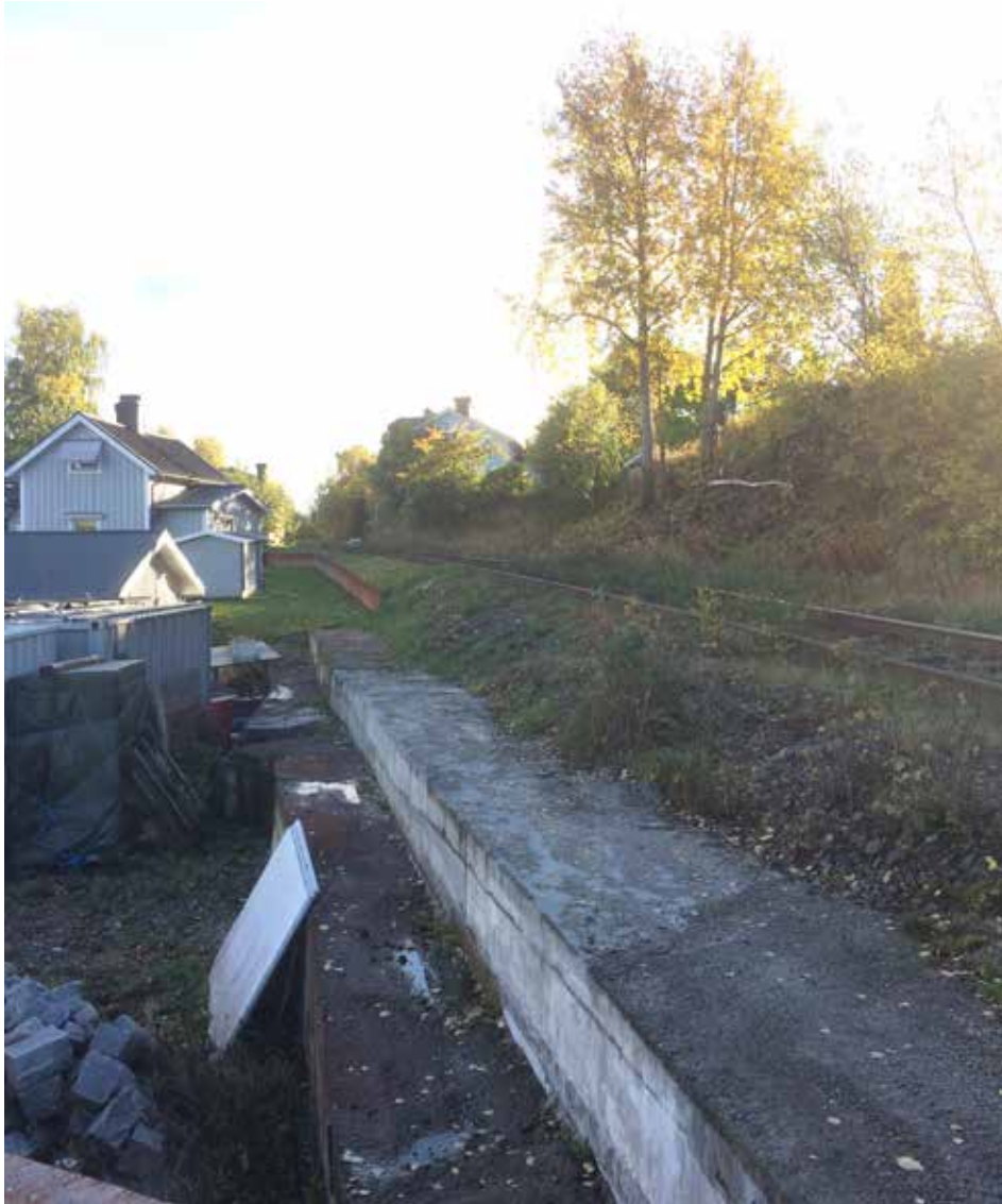
Figur 7:1 Vy längs norra delen av Tunadalsspåret
