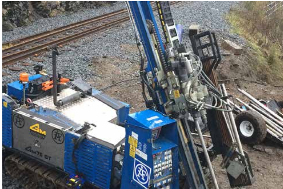
Figur 5.1:8 Jordprovtagning med geoteknisk borrhbandvagn
