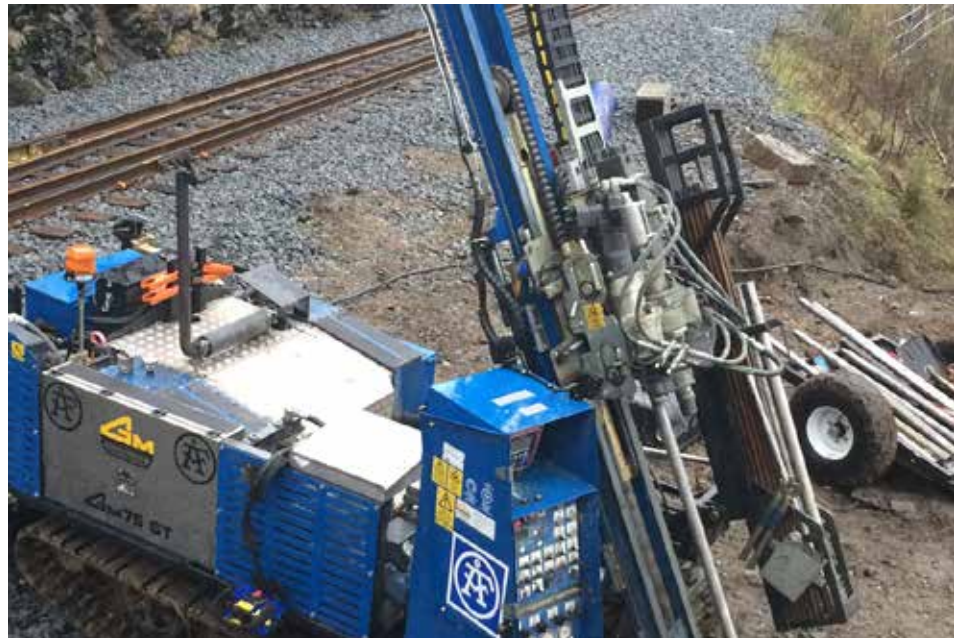
Figur 5.1:8 Jordprovtagning med geoteknisk borrhandsvagn
