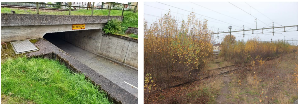
Figur 27. Till vänster ses gång- och cykelpassage under järnvägen, bild tagen från järnvägens norra sida, mot söder. Till höger ses upptrampad stig över bangården, bild tagen från järnvägens norra sida mot söder.
