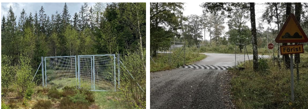
Figur 6. Exempel på grind i viltstängslet (bild till vänster) och färst (bild till höger) vid anslutningar till väg 25.
