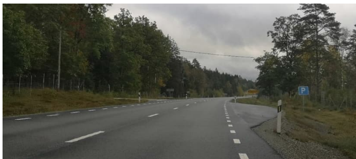
Figur 4. Väg 25 med en nöduppställningsficka invid väggkanten. Viltstängsel finns utmed vägens båda sidor.
