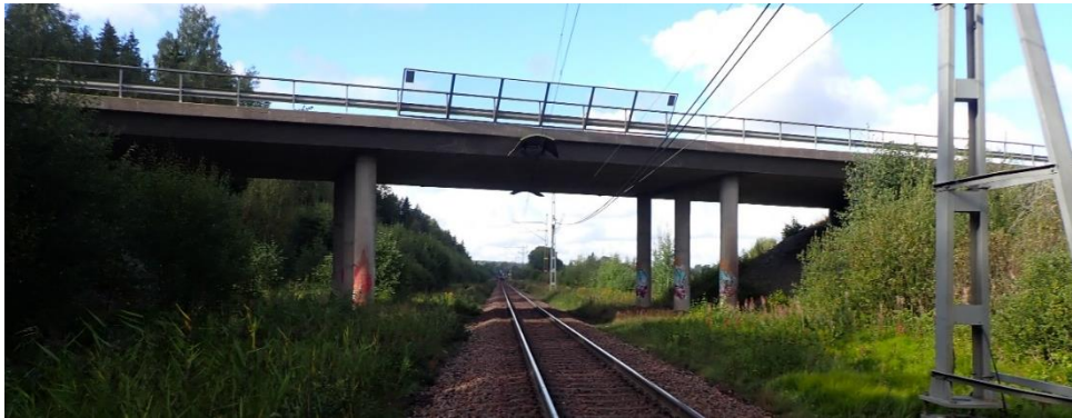
Figur 23. Befintlig bro 17-908-1. Foto: BaTMan.
