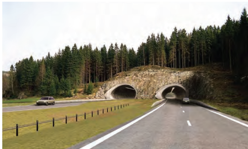
Figur 4.4:29 Exempel på tunnelmynning med enkel, eliptisk utformning.
