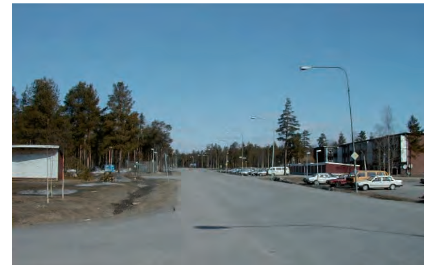
Figur 4.4:19 Lutande stolpar ger ett rörligt vägrum vilket förstärks av långa armaturarmar.
