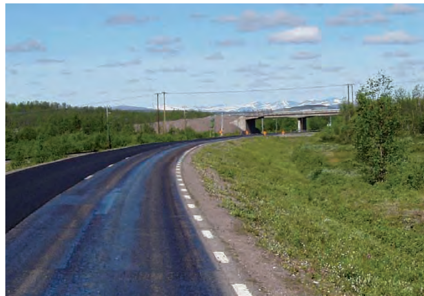
Figur 4.3:2 Väg E 10 norr om staden där vegetationen är låg och där utblickar mot fjälltoppar ges. Vägbro för tung trafik till LKAB syns.
