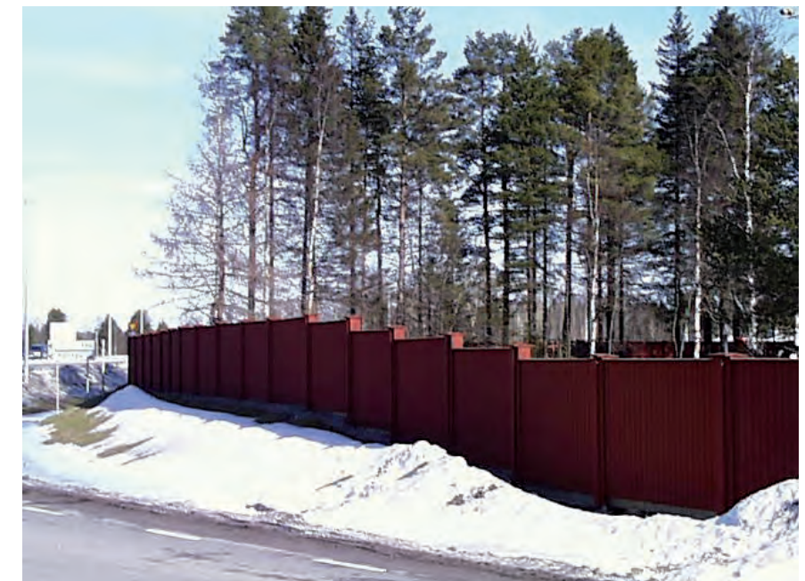
Figur 4.4:21 Exempel på en bullerskärm som vid måttlig marklutning följer terrängen genom trappning.
