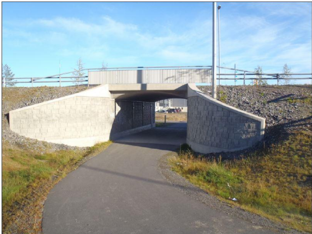
Figur 13. Exempel på gång- och cykelpassage av betong
