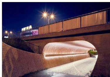
Indirekt belysning i gångtunnel. Exempel.
