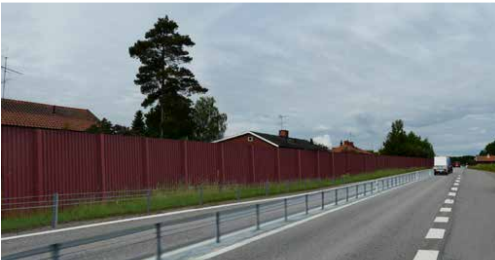
Två meter högt och 180 meter långt vägnära bullerskyddsplank vid Örminge. Planket ger en kraftig barriäreffekt då det splittrar bebyggelsen på ömse sidor om vägen. Bystrukturen där vägen tidigare samlat bebyggelsen delas nu istället upp.
