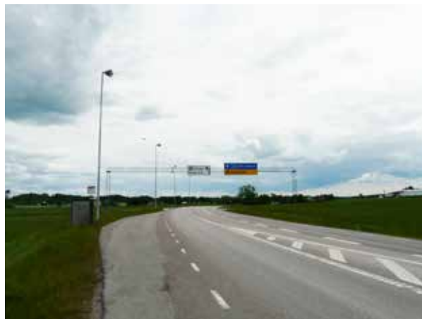
Skyltportal vid korsningen in till Vårdsbergs kyrka.
