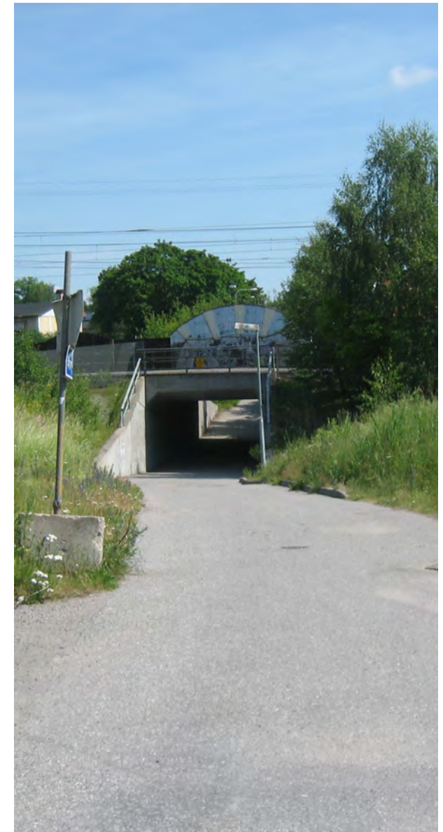
Figur 4.2.1 Befintlig planskild korsning vid Historievägen
