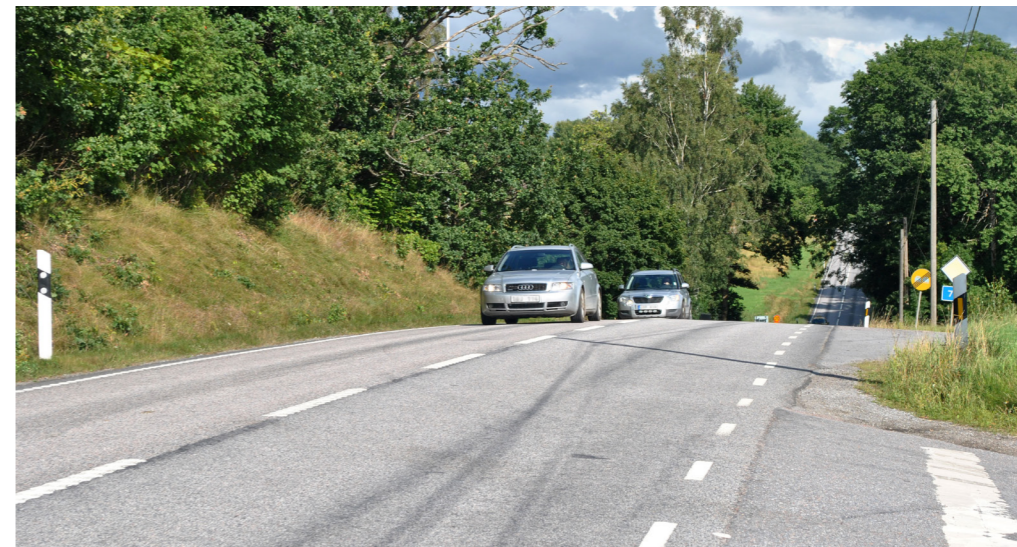
Väg 77 har ett körfält i vardera riktningen utan mitträcke. Vägbreddens är endast cirka 6,5 m bred och respektive körfält är 3m.
