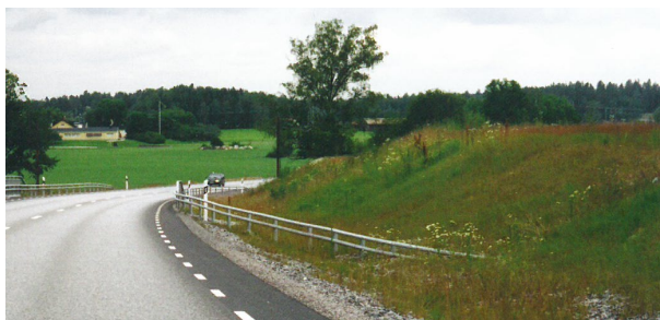
Figur 3.1.6-2. Räckesänden svängs ut och förankras i bakslänten, en både trafiksäker och estetiskt tilltalande lösning. Källa: Vägen, en bok om vägarkitektur (2006).
