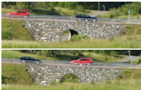
Figur 3.2.3-2. Trafikplats Frötuna, Norrtälje. Referens där trafikverket tidigare stabiliserat slänt kring trumma med sprängsten i jordfuktat bruk. Källa: Google streetview (2020).
