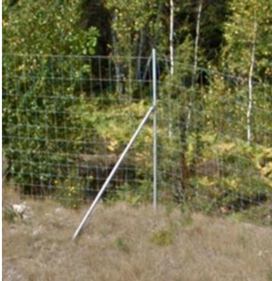
Figur 16 Exempel på stagning av stängsel
