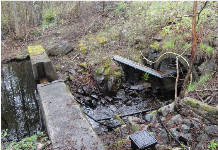
Figur 13: Fotograf av den damm som finns i utloppen från Ältaren söder om Björndammen, samt trumman med hylla för medelstora däggdjur som leder vattendraget under väg 55.
