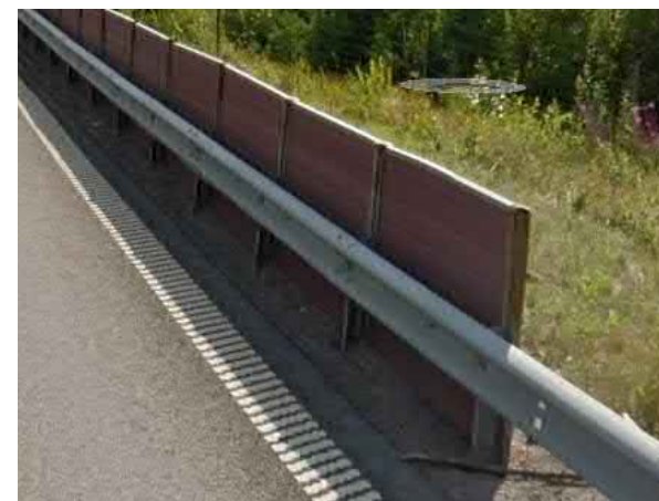
Figur 3.2.3-3. Trafikplats Karlsvik, Mellan Falun och Borlänge. Referens där trafikverket tidigare monterat låga bullerskrämmor mot vägräcka, här med faluröd panel. Källa: Google streetview (2020).
