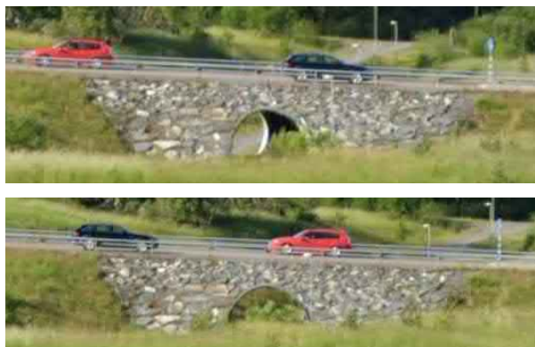
Figur 3.2.3-2. Trafikplats Frötuna, Norrtälje. Referens där trafikverket tidigare stabiliserat slänt kring trumma/rörbro med sprängsten i jordfuktat bruk. Källa: Google streetview (2020).
