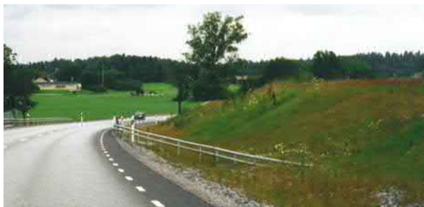
Figur 3.1.6-2. Räckesändan svängs ut och förankras i bakslänten, en både trafiksäker och estetiskt tilltalande lösning. Källa: Vägen, en bok om vägarkitektur (2006).
