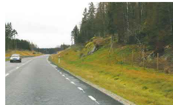
Figur 3.1.7-1. Slänter klädda med avbaningsmassor. Källa: Vägen, en bok om vägarkitektur (2006).
