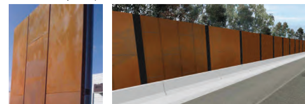
Figur 3.2.3-4. Referensbild, skärm i rosttrött stål. Källa: Government of South Australia.
