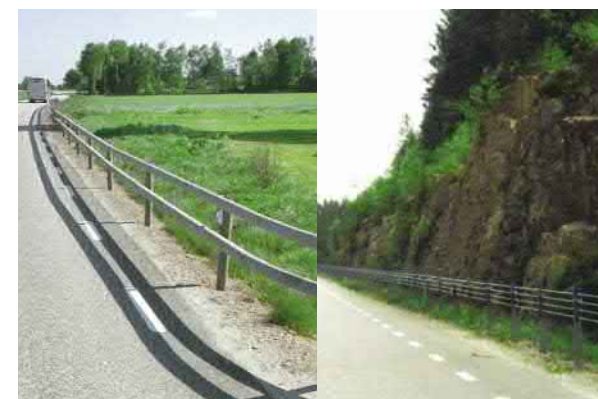
Figur 3.1.6-1. Rörräcken och ställineräcken är exempel på räckestyper som båda har god genomsikt. Källa: Vägen, en bok om vägarkitektur (2006).
