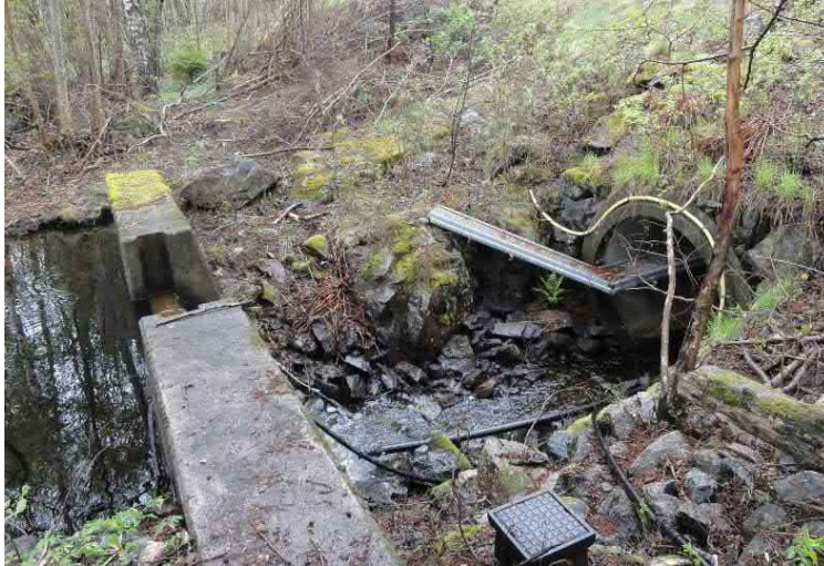
Figur 14: Fotografi av den damm som finns i utloppen från Ältaren söder om Björndammen, samt trumman med hylla för medelstora däggdjur som leder vattendraget under väg 55.
