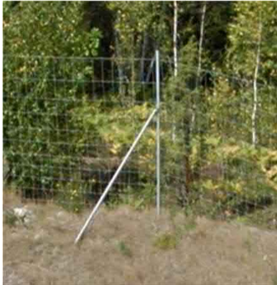
Figur 17: Exempel på stagning av stängsel.
