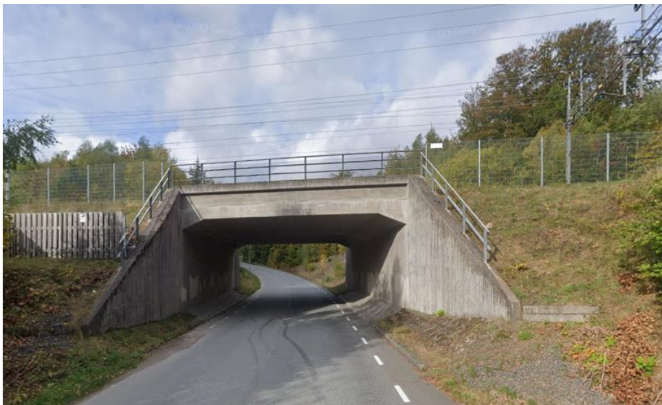
Figur 4.6.1–1. Befintlig passage strax norr om Tjörnarp. Bild från Google Street view.
