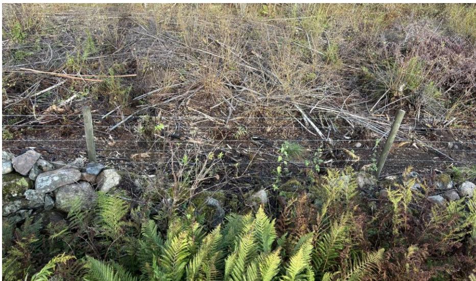
Figur 4.5.6.2–3. Stenmur längs järnvägen med befintligt stängsel som föreslås rivas och ersättas med nytt bredvid muren.
