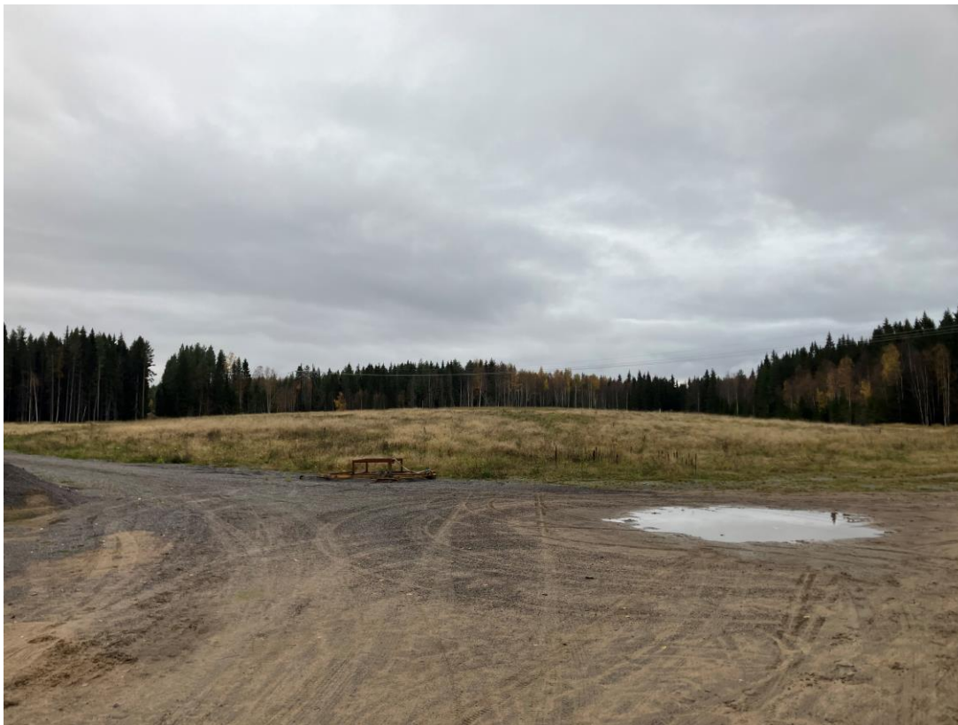
Figur 8. Exempelbild som visar avslutad och efterbehandlad sulfidjordsdeponi före återbeskogning (Sunderbyn, Norrbotten). Högsta punkten på deponin når cirka sex meter över markytan. Foto: Lisa Cullhed, Trafikverket.
