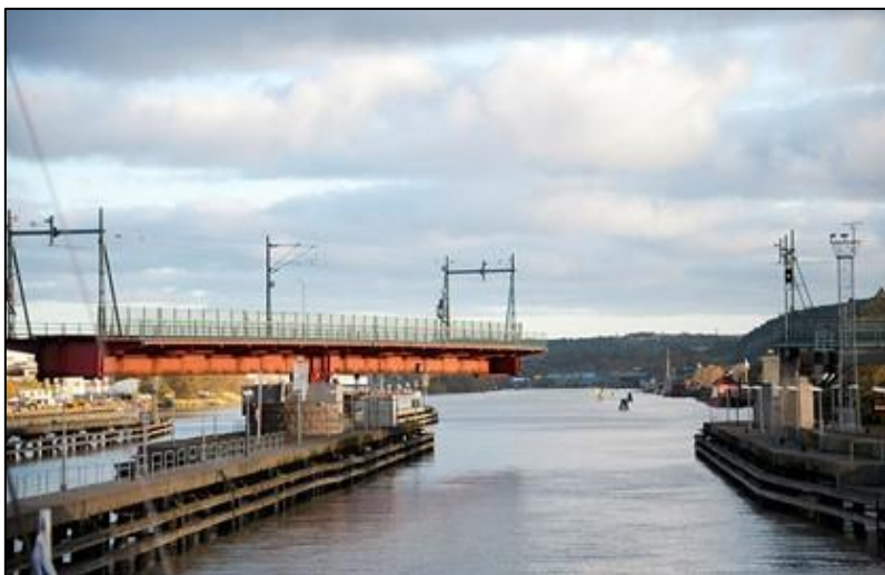
Figur 41: Järnvägsbro i Marieholm, en svängbro (Källa: Trafikverket)
