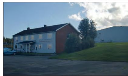
Figur 4.4:5 Föreningshuset vid idrottsplatsen söder om Byskeälven.
