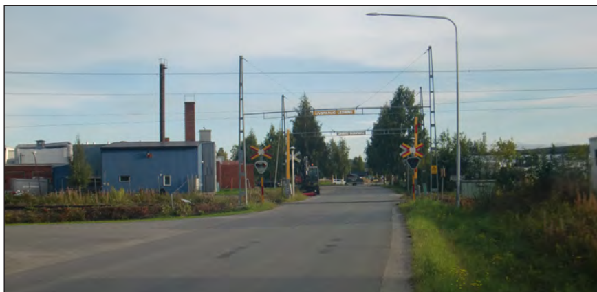
Figur 4.4:2 Arbetsplatsområde längs med befintlig järnväg.
