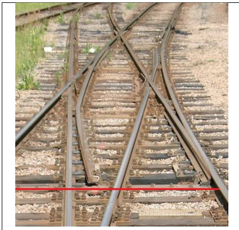
Fig. 13. Stoppgränser vid enkel korsningsväxel
