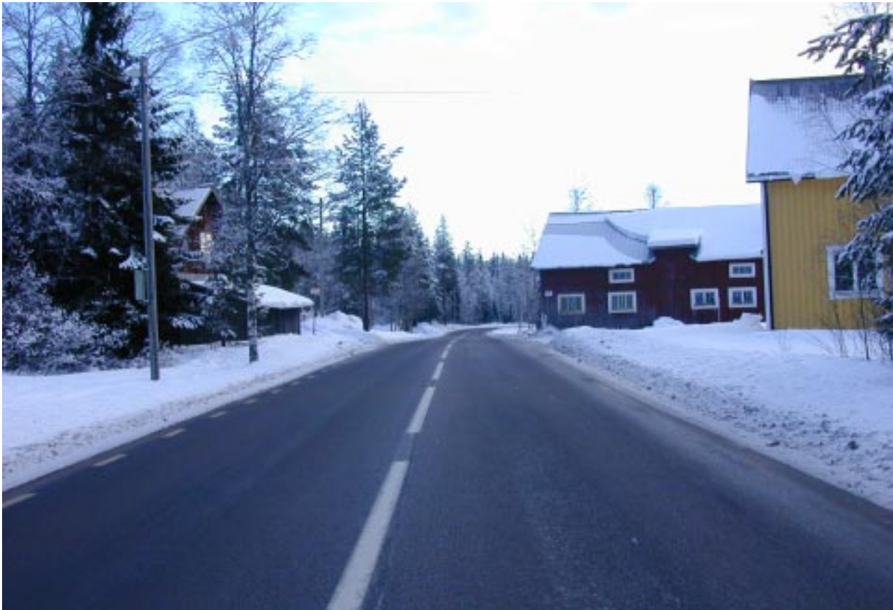
Före: Trång passage på befintlig väg 297 i Östra Tandö. Bilden tagen i riktning norrut.
