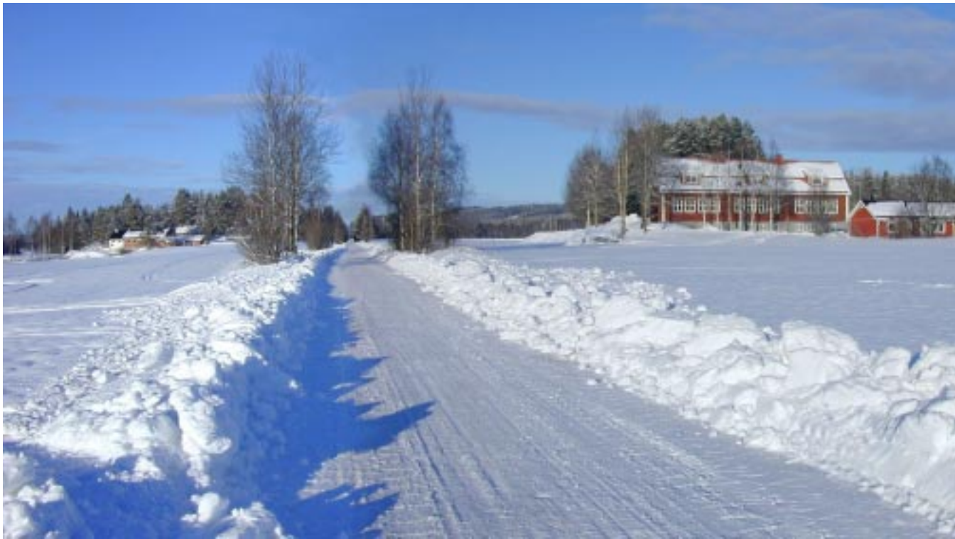
Före: Vid Rissätra gamla skola. Bilden tagen från järnvägsbanken i riktning norrut.
