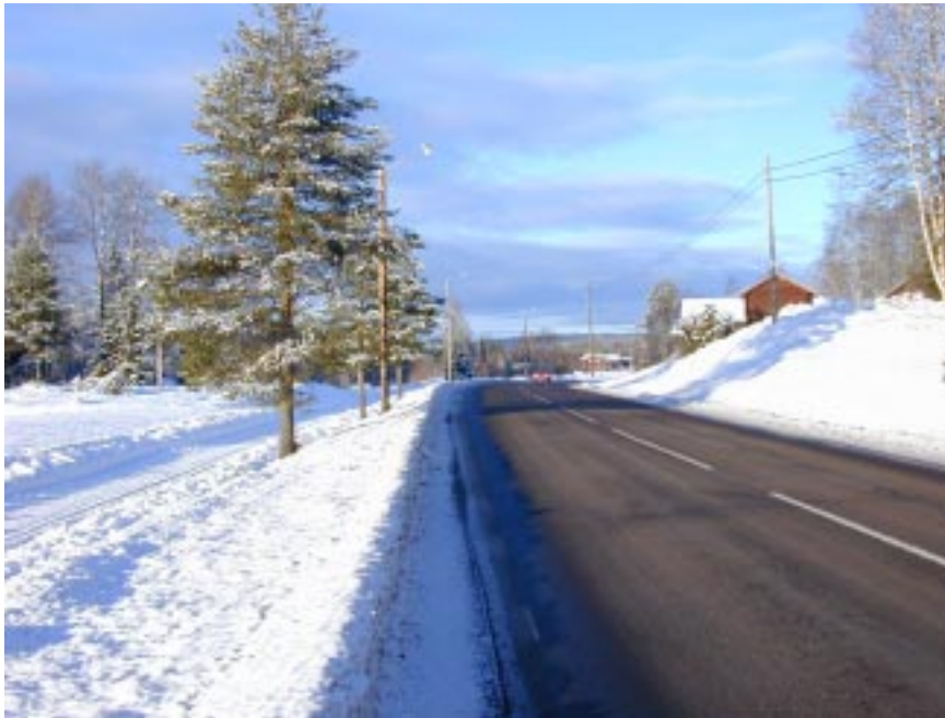
Befintlig väg 297 vid Östra Lillmon. Bilden tagen norrut.
