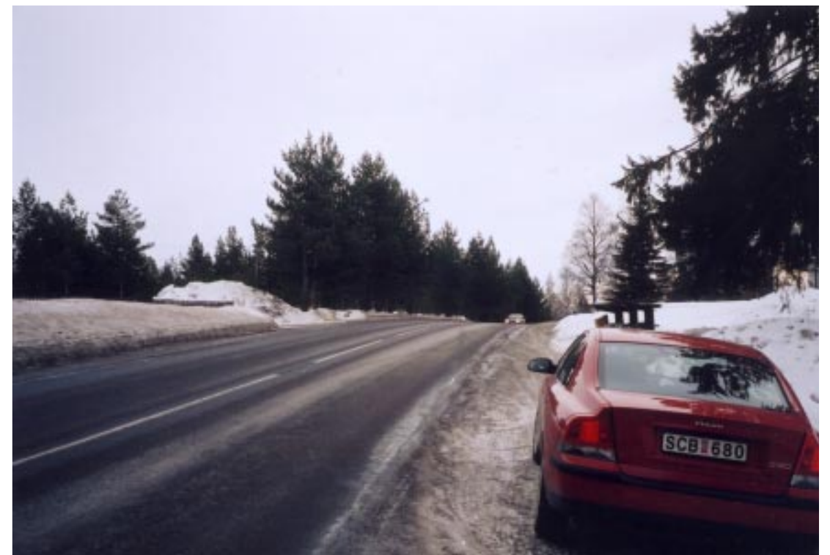
Den geometriska standarden är låg på aktuell sträcka av väg 297. Bilden visar ett backkrön med skymd sikt.
