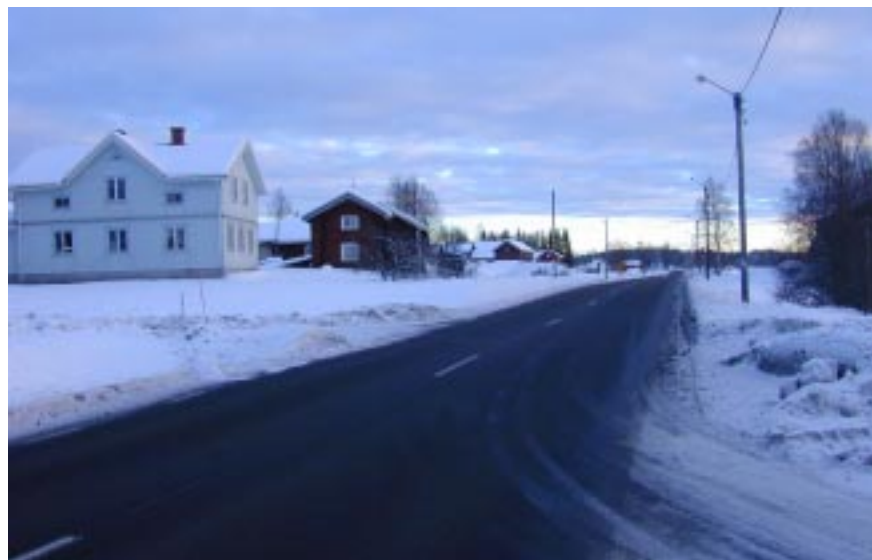
Före: befintlig väg 297 vid Rissätra.
