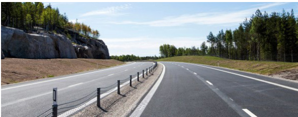
Figur 3. Exempel på mötesfri väg med 2+2-körfält.
