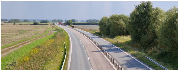
Figur 2. Exempel på mötesfri väg med 2+1-körfält.
