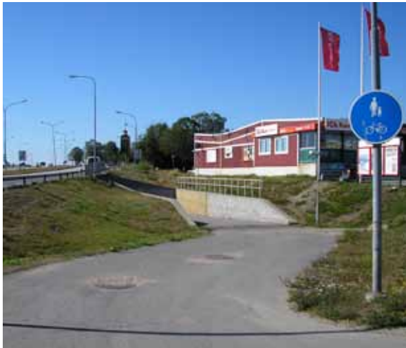
Befintlig gång- och cykeltunnel.
