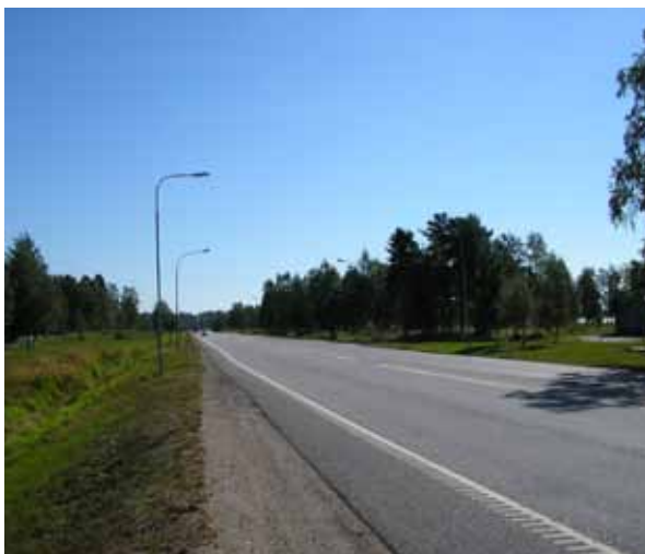
Vägmiljö på delen norr om Nygatan.
