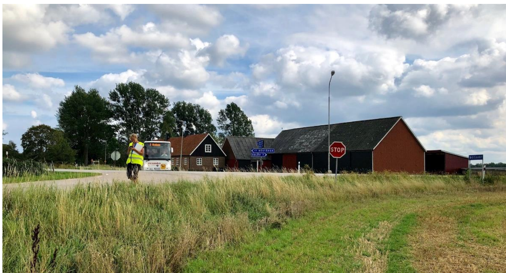
Figur 13: En byggnadssamling med kulturhistoriskt värde finns i Öslöv, i sträckans norra del.
