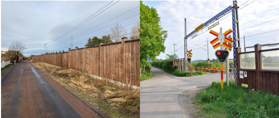
Figur 4. Befintlig bullerskyddsskärm i Bergsbrunna. Till vänster visas en del av skärmen längs Banvägen. Till höger visas skärmens öppning vid Gårdsvägen.
