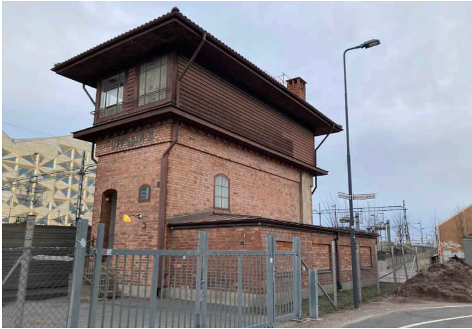
Figur 52. Ställverket med befintlig tillbyggnad från 1930-talet.
