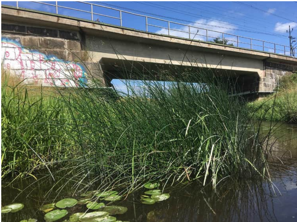
Figur 30. Befintlig bro över Sävjaån.
