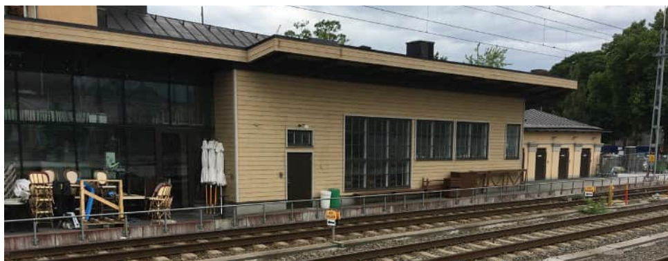
Figur 14. Uppsala centralstation, träfasad (vy mot nordväst).
