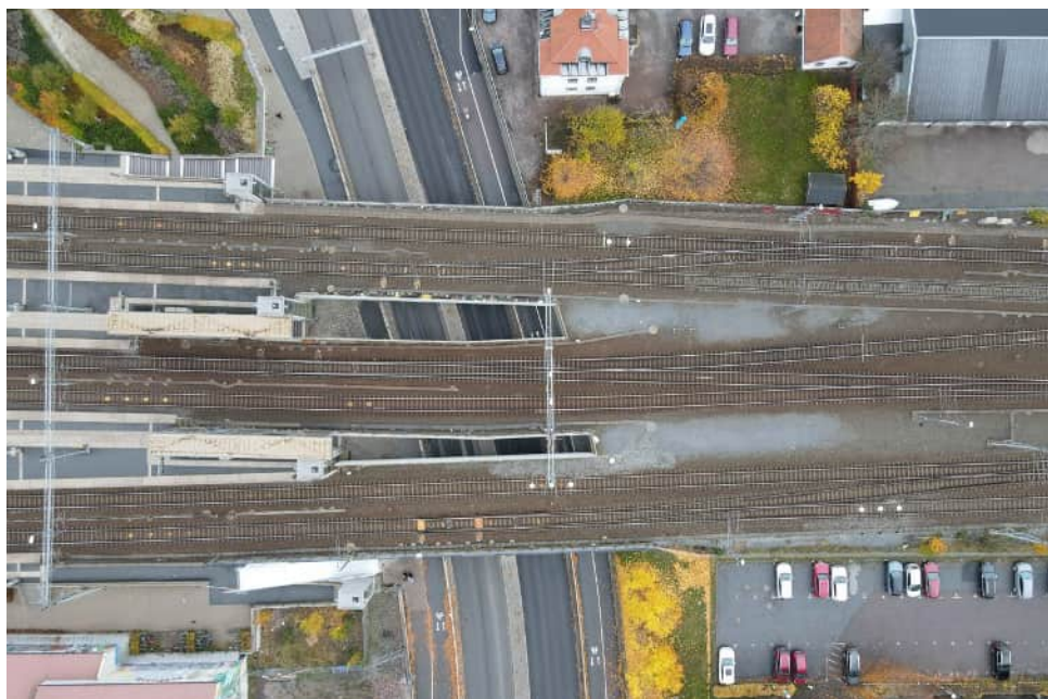
Figur 10. Befintliga broar över Strandbodgatan.
