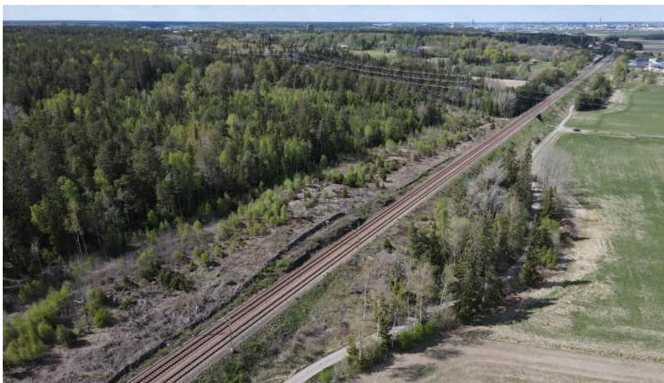
Figur 31. I förgrunden syns platsen för planerad station, Uppsala Södra. Bortanför, på vänster sida av järnvägen, syns nordöstra delen av Lunsen (vy mot Nordväst).
