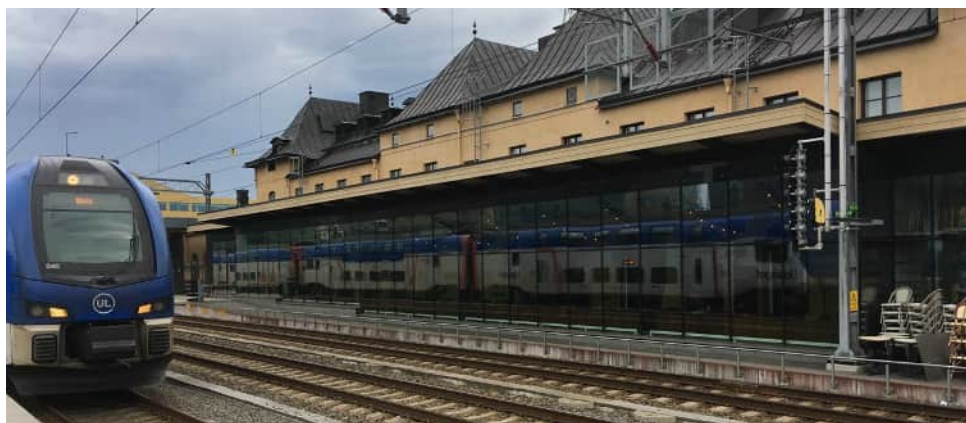
Figur 15. Uppsala centralstation, glasveranda (vy mot sydväst).
