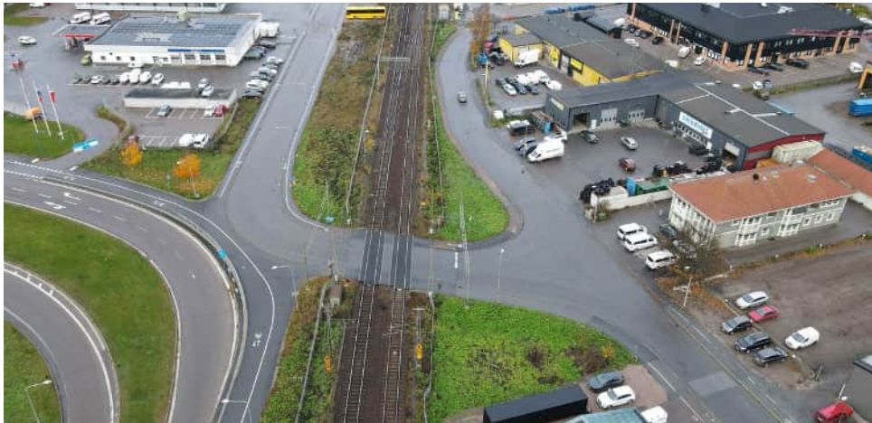
Figur 11. Befintlig planpassage vid Vimpelgatan.
