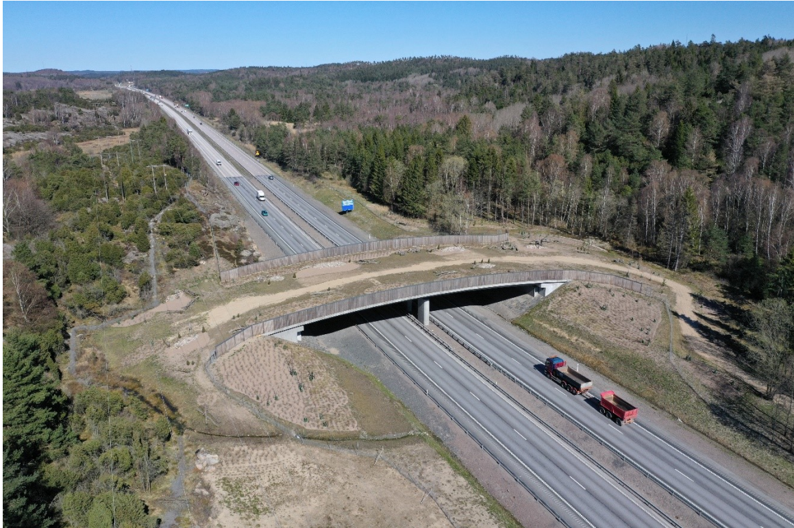
Figur 6. Foto på en faunapassage som liknar den som föreslås i denna vägplan (Foto: Enviroplaning AB).
