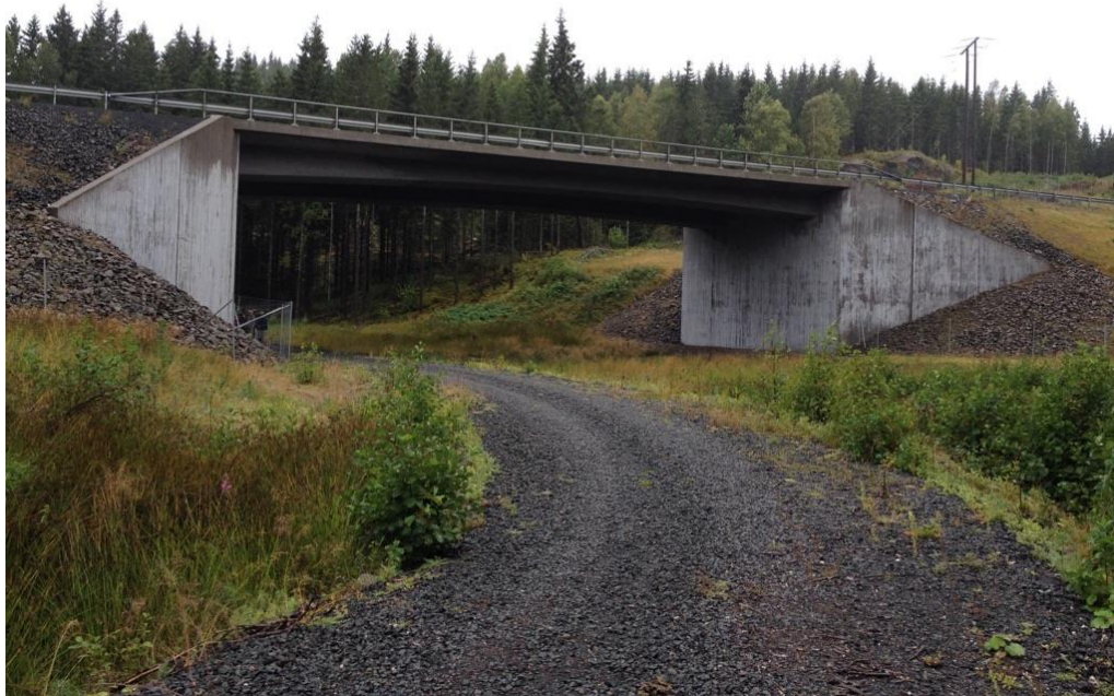
Figur 4. Exempel på vägport anpassad för viltpassage, denna under väg 31 nordost om Tenhult (foto Henrik Wahlman).
