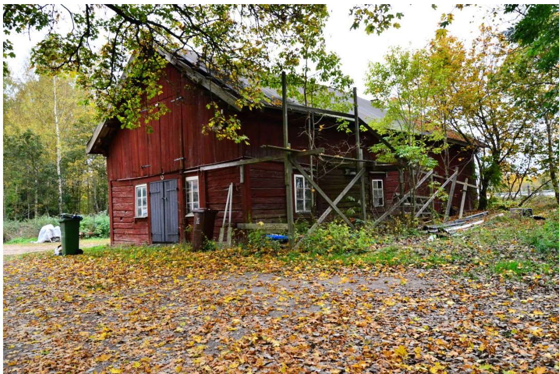
Byggnad som kommer att behöva rivas när ny väg byggs, Hallstahammar Berga 4:11
