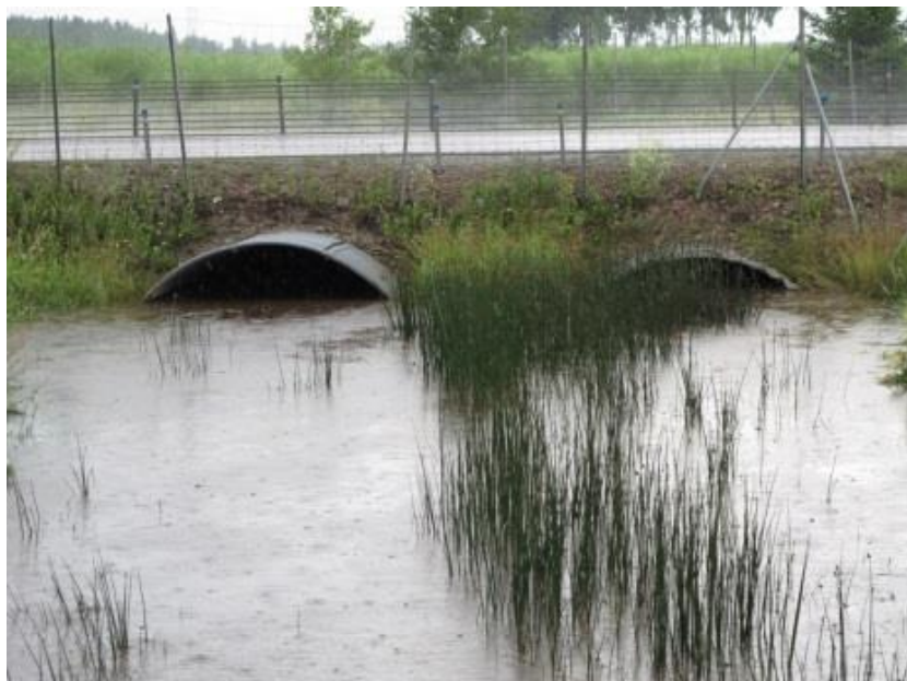
Figur 17: Befintlig vägbro över vattendrag där vattenlevande organismer kan passera och där torrtrumma anordnas för att även möjliggöra utterpassage.
