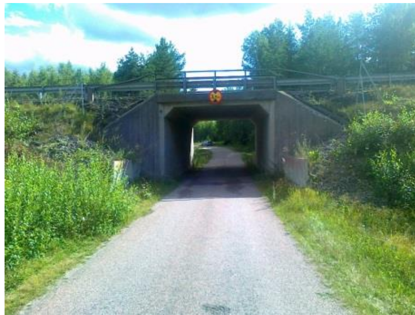
Figur 16: Befintlig vägport där både större och mindre däggdjur kan passera under vägen.
