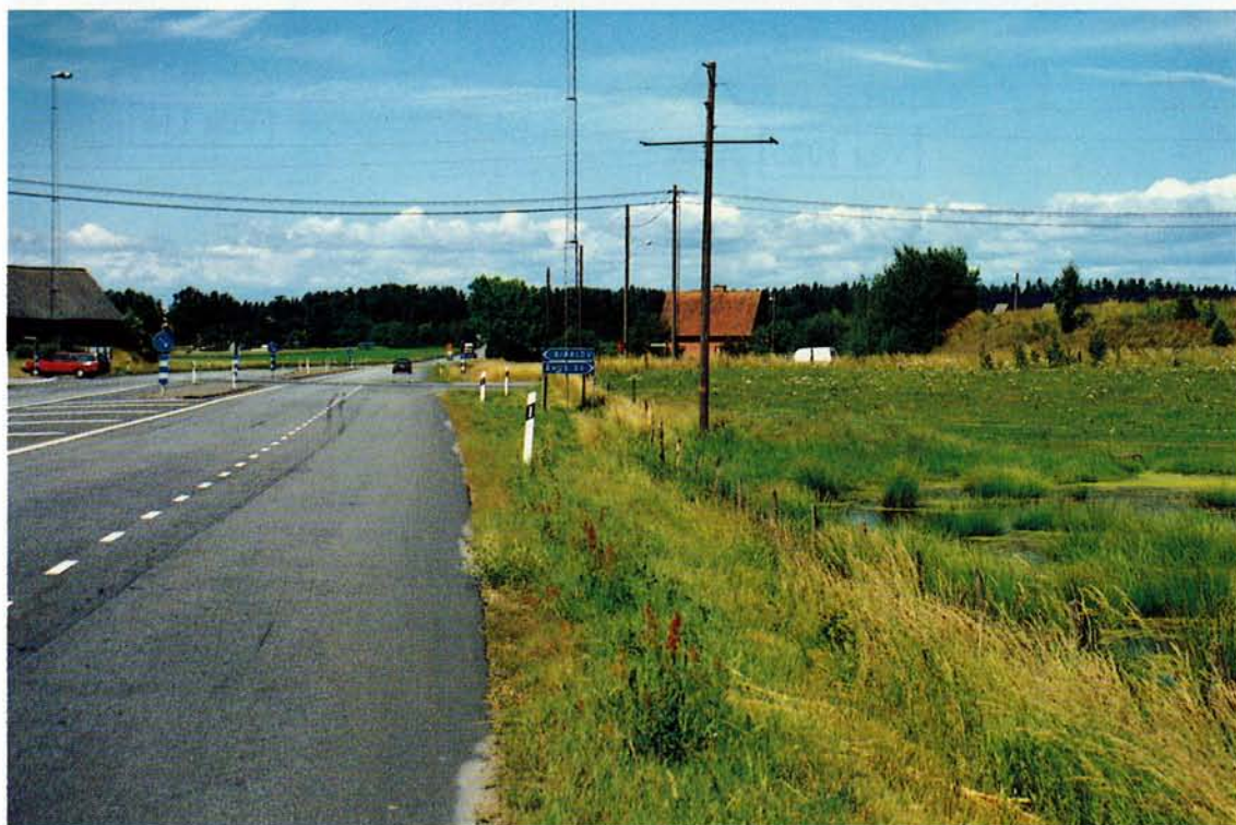
Bild 6.5.11 Korsning med väg 118 sedd söderifrån
