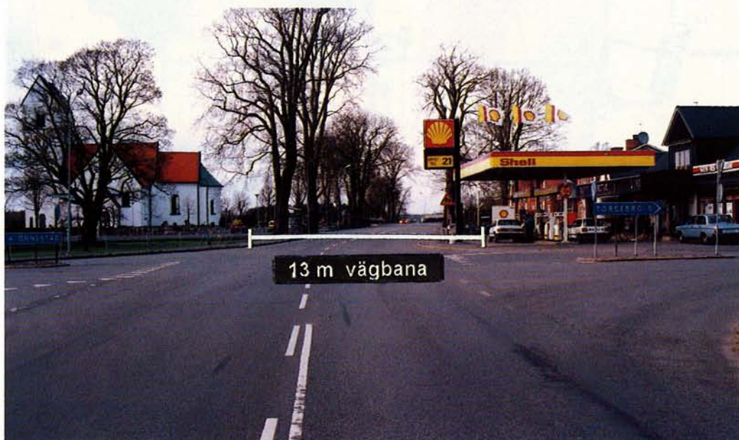
Bild 6.41 Korsning mellan väg 19 och väg 1013, vy från söder
