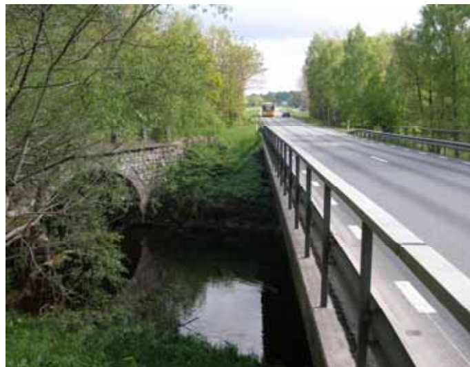
Befintlig väg 19 vid passagen av Almaån.
