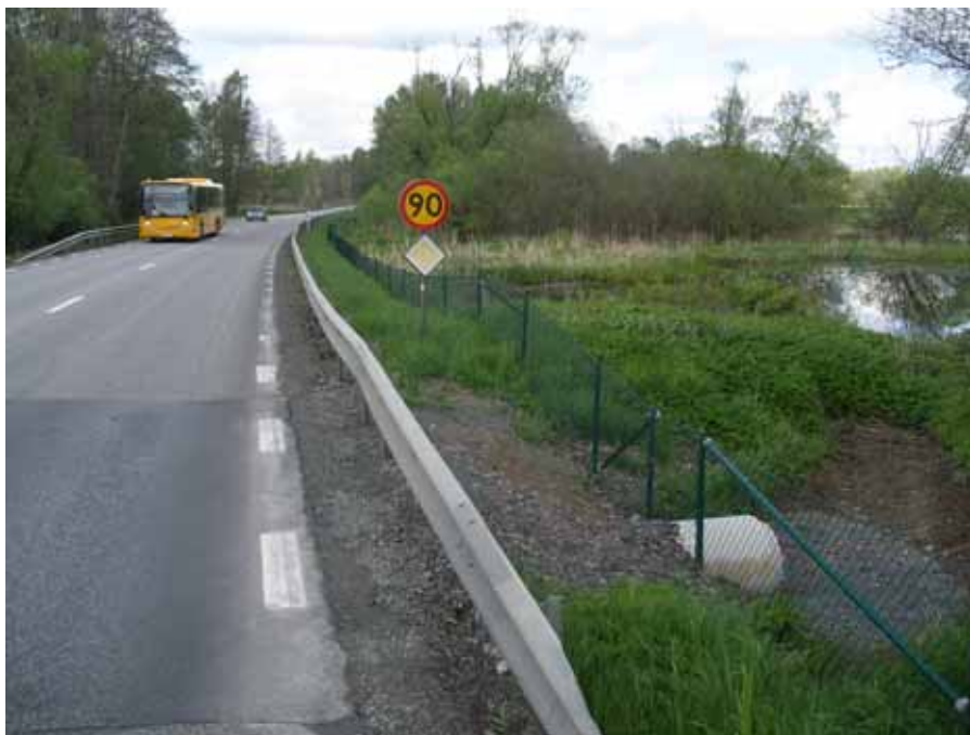
Utterpassage i form av trumma under väg 19 vid sidan om Olingeån.
