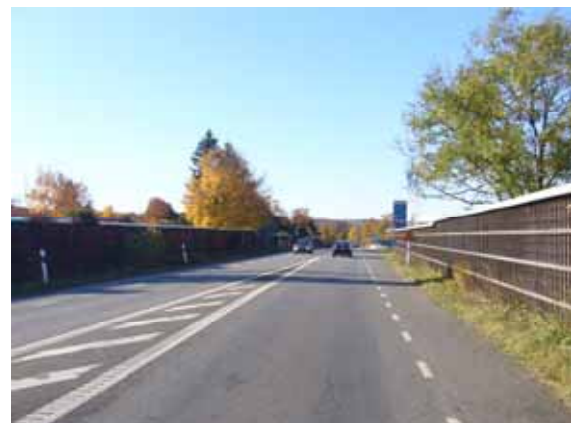
Exempel på bullerskydd vid genomfart (E22 i Tollarp).
