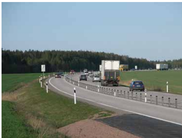
Mötesfri landsväg med omkörningsfält, 2+1 körfält.
