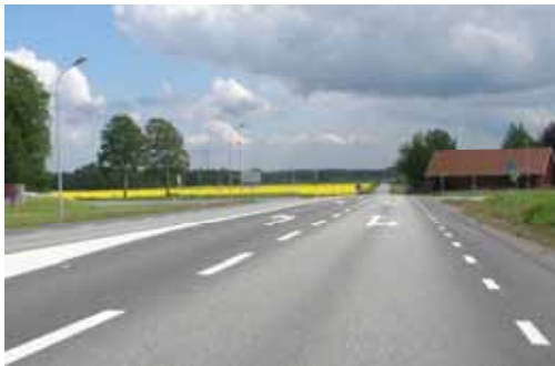
Befintlig väg 19 vid korsningen med väg 2054 i södra Knislinge.
