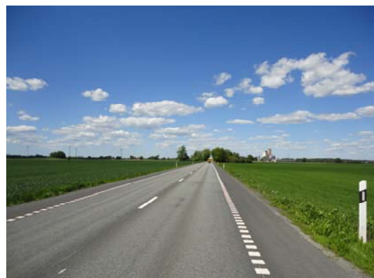
Befintlig väg 19 mellan Härlöv och Karpalund.
