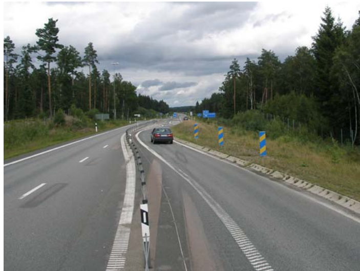
Exempel på hastighetssänkande åtgärd i plankorsning (Väg 23 utanför Ballingslöv).
