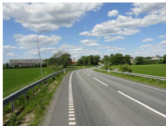
Linjeföringen på befintlig väg 19 förbi Karpalund har relativt låg standard.
