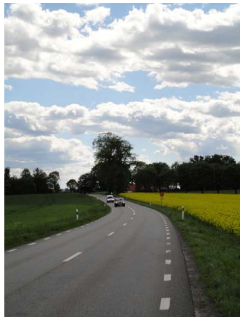
Befintlig väg 19 mellan Färlöv och Bjälöv.
