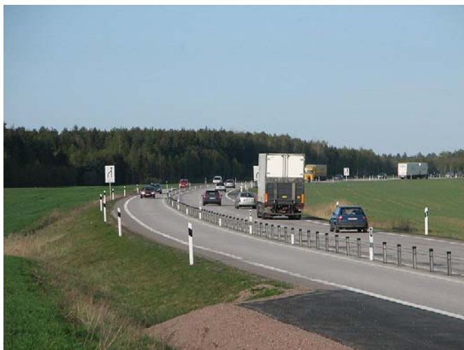
Mötesfri landsväg med omkörningsfält, 2+1 körfält.
