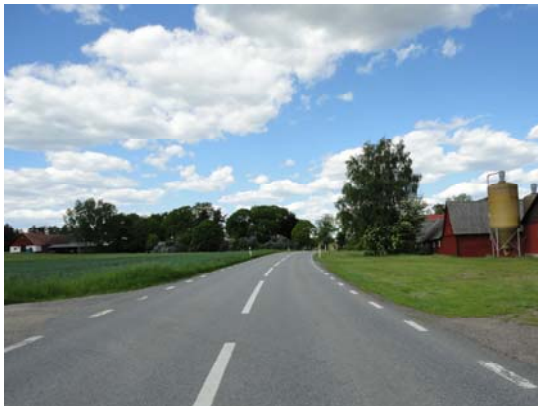
Befintlig väg 19 förbi gårdarna Sigridsfält och Roslätt.
