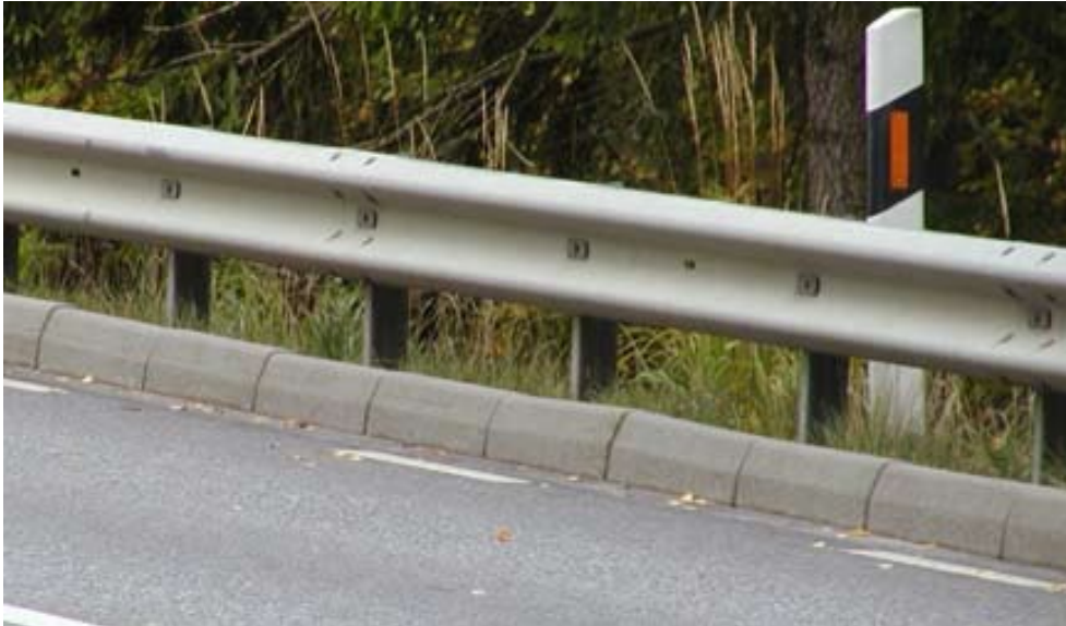
Åtgärder i form av kantsten och räcke.
