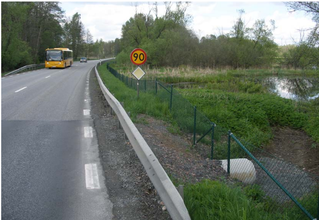
Utterpassage i form av trumma under väg 19 vid sidan om Olingeån.
