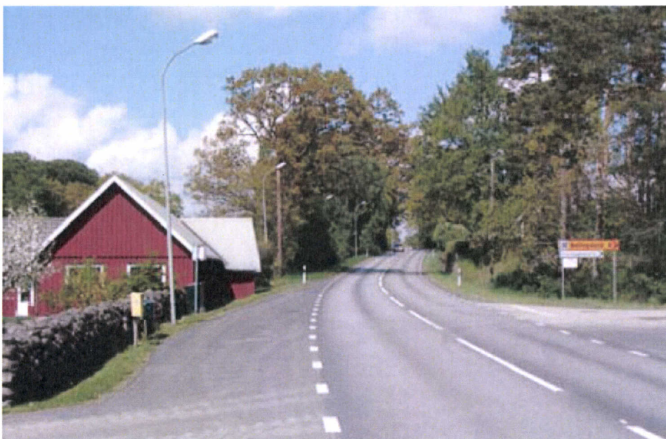
Befintlig väg 19 i södra delen av Bössebacken
