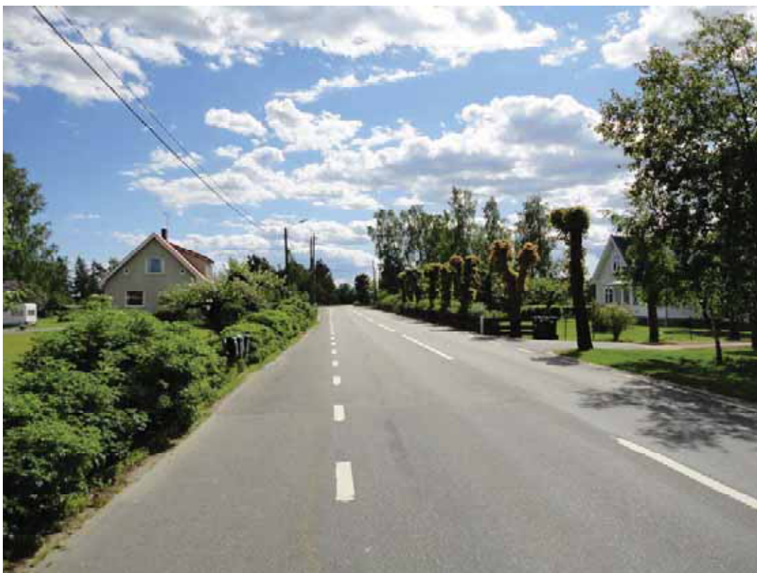
Trång passage vid Villagården med närliggande bebyggelse på båda sidor om vägen.
