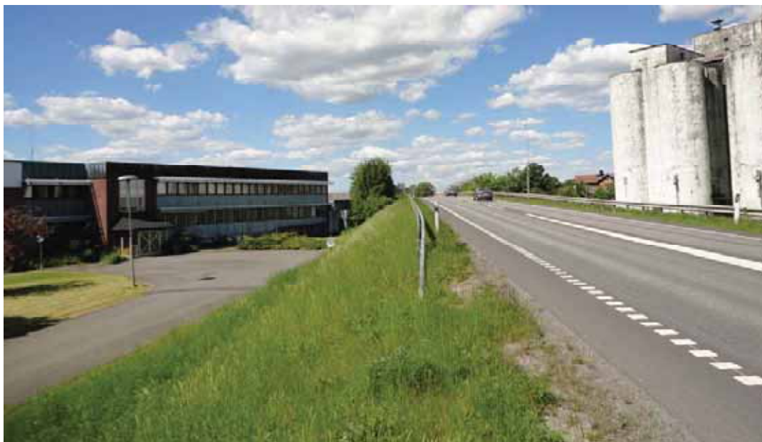
Campbells respektive Kristianstads Lagerhusförening ligger tätt intill vägbanken där väg 19 passerar över järnvägen mellan Kristianstad och Hässleholm.
