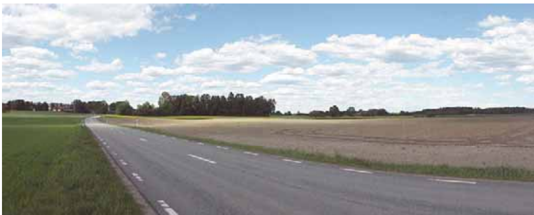
Befintlig väg 19 vid läget för den föreslagna plankorsningen.
