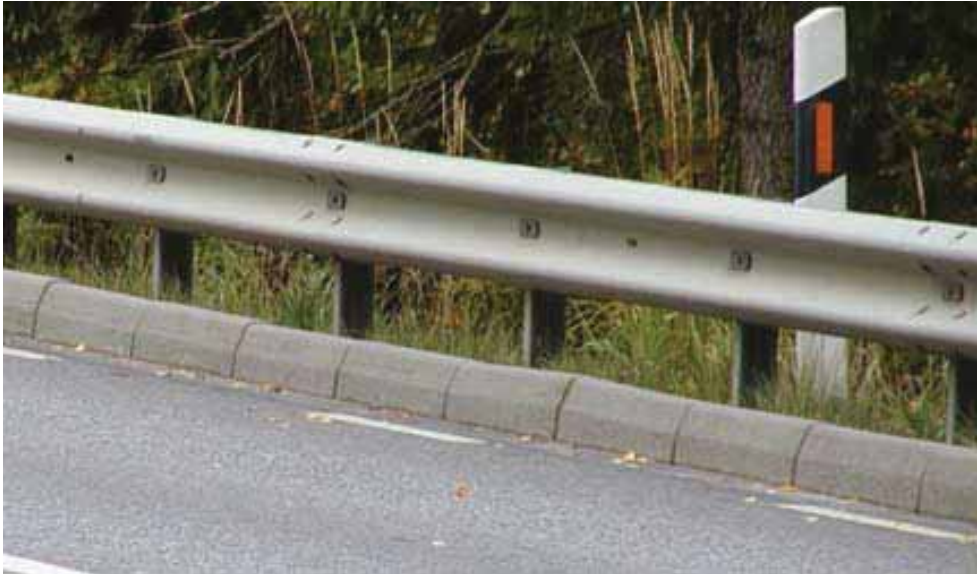
Åtgärder i form av kantsten och räcke.
