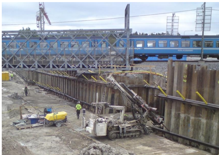
Figur 4 Spårbro och spont för Roslagsbanan vid byggande av Bergtorpsvägen i Täby.
