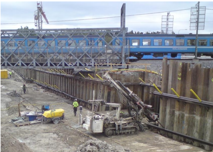
Figur 9 Tillfällig spårbro och spont för Roslagsbanan vid byggande av Bergtorpsvägen i Täby.
